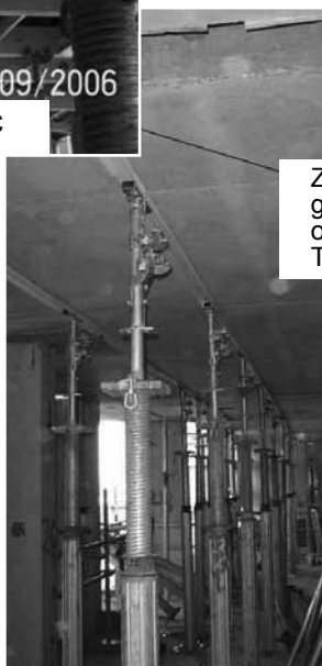
Zastosowanie głowicy opadającej TOPEC
